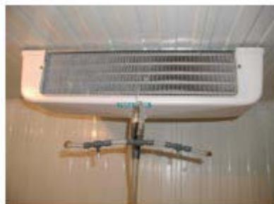
**Fig. n°4.- Situación del distribuidor del ozono, para facilitar la homogeneización de la atmósfera interior.**
